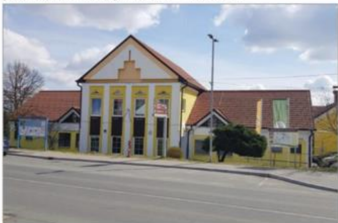
Objekt OŠ Cerkvenjak bo še poleti dobil nov plašč in barvo.
